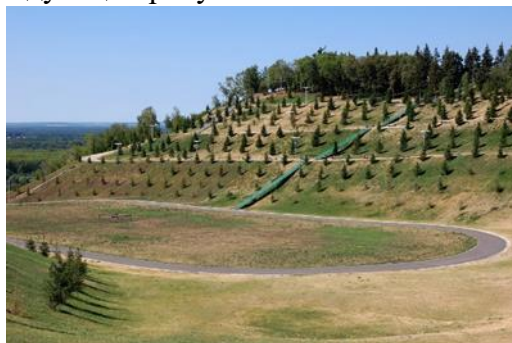
Рис. 2.10.1-1, 2.10.1-2 Высаживание деревьев и кустарников на склонах
